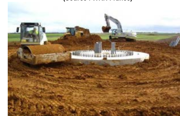
Photo 55 : Remblaiement de la fondation (Source : WKN France)
