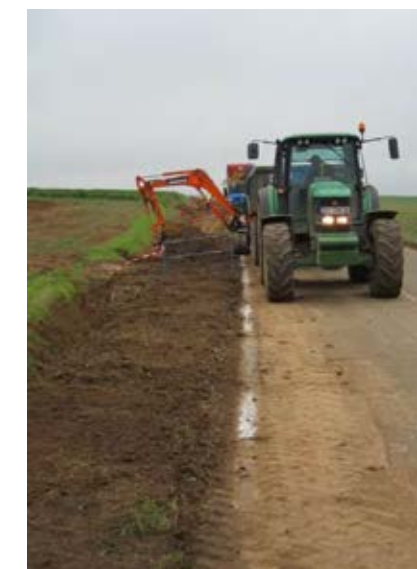
Photo 61 : Exemple de tranchée (Source : WKN France – Parc éolien de Dargies)
