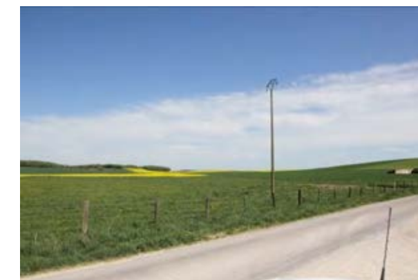
Photo 45 : Ligne électrique 20 kV à proximité de Mirbel
