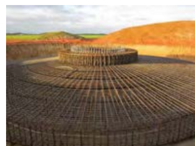
Photo 52 : Ferrailage de la fondation (Source : WKN France)
