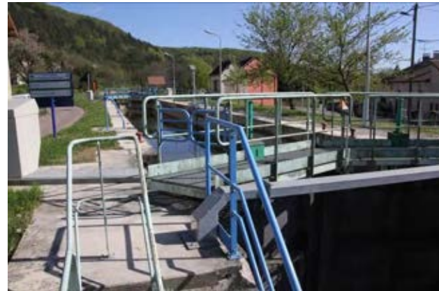
Photo 27 : Ecluse à hauteur de Vouécourt
