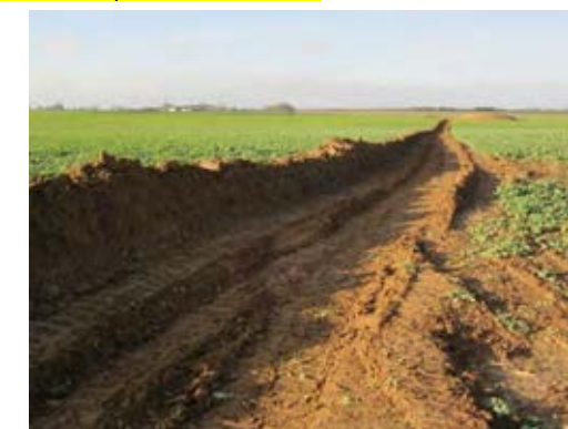
Photo 62 : Exemples de création de chemin d'accès (Source : WKN France – Parc éolien de Dargies)
