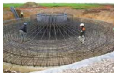
Photo 51 : Béton de propreté coulé et mise en œuvre de l'anchor cage (Source : WKN France)
