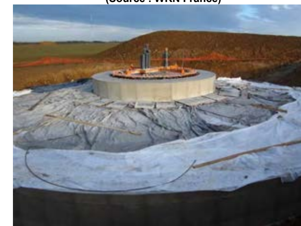
Photo 54 : Mise en œuvre du revêtement d'étanchéité (Source : WKN France)
