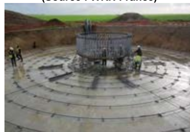
Photo 51 : Béton de propreté coulé et mise en œuvre de l'anchor cage (Source : WKN France)
