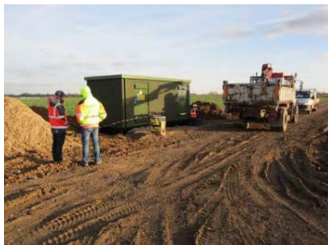
Photo 64 : Exemples d'installation d'un poste de livraison et de passages de camion
