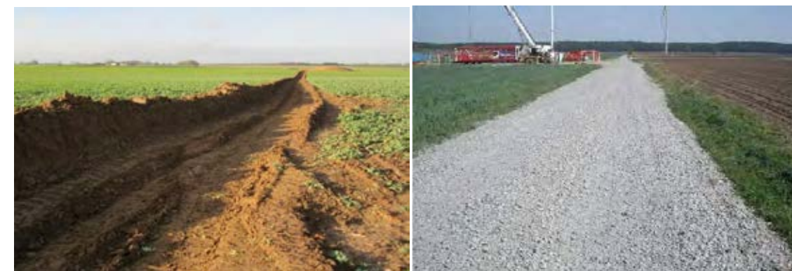
Photo 49 : Exemple de réalisation d'accès
