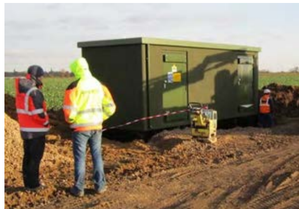
Photo 48 : Exemple de poste de livraison en cours d'installation (Source : WKN France)
