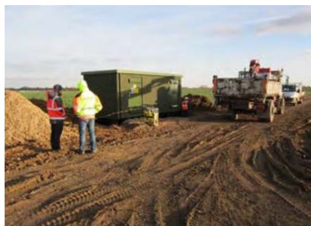
Photo 57 : Installation du poste de livraison (Source : WKN France)
