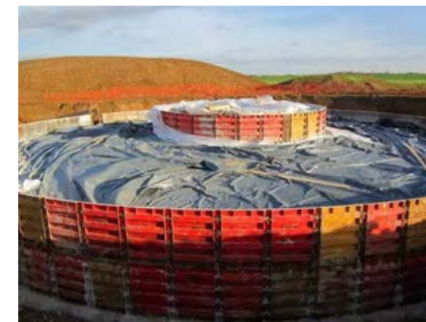
Photo 53 : Coffrage de la fondation (Source : WKN France)
