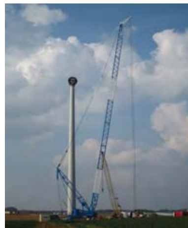
Photo 56 : Montage d'une éolienne (Source : WKN France)
