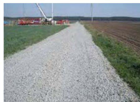
Figure 45 : Vue d'une voie d'accès
