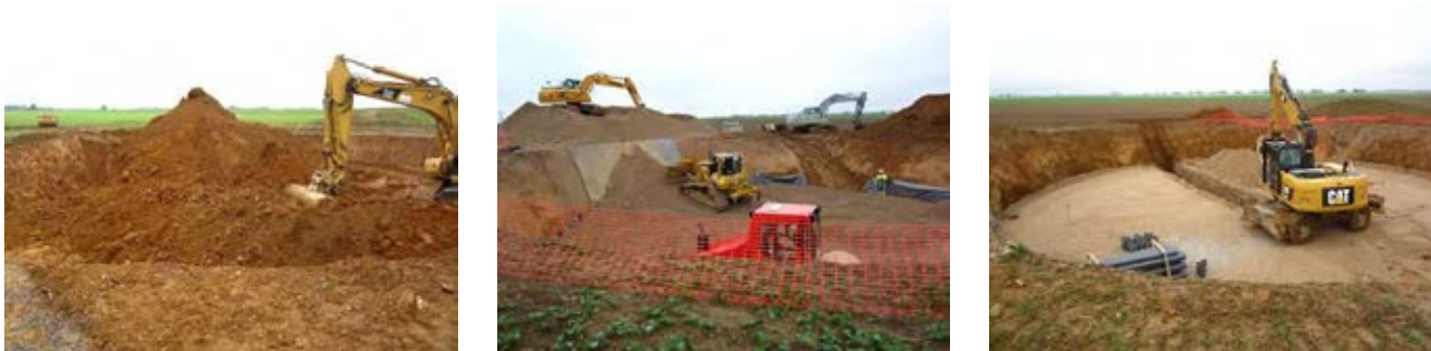
Photo 63 : Exemples de préparation du sol pour la mise en place d'une fondation d'éolienne
