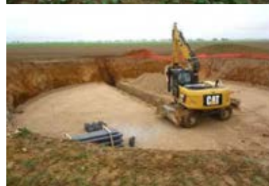
Photo 50 : Excavation pour la fondation (Source : WKN France)
