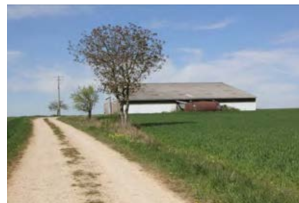
Photo 44 : Ligne électrique 20 kV desservant le hangar agricole au sud de l'aire d'étude immédiate
