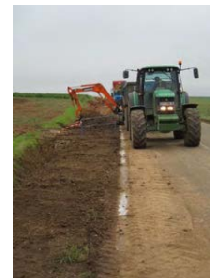
Photo 59 : Exemple de tranchées de raccordement en bord de route (Source : WKN France)
