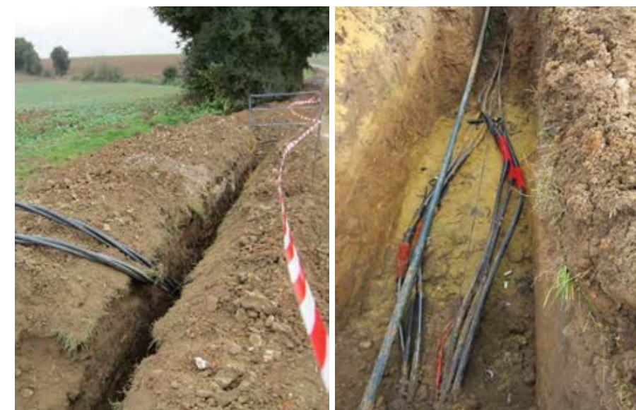
Photo 58 : Exemple de tranchées de raccordement (Source : WKN France)
